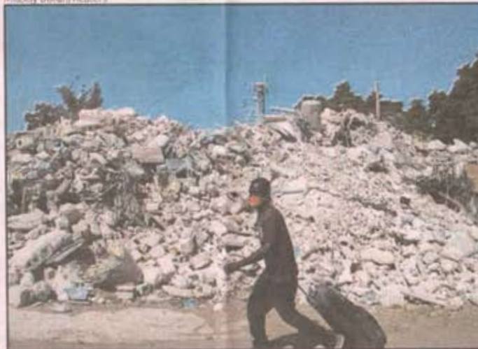
Prédios destruídos no Haiti: tecnologia poderia ter amenizado a catástrofe
