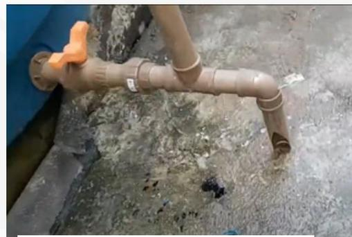
Figura 2: Tubo extravasor sem tela de proteção
