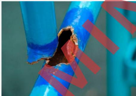
Figura 6: Corrosão em tubulação de água fria
