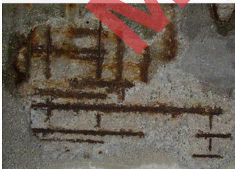
Figura 1: Armadura exposta das paredes de um reservatório
