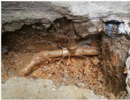
Figura 4: Vazamento em tubulação aparente
