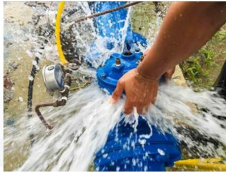
Figura 3: Vazamento em bomba de recalque
