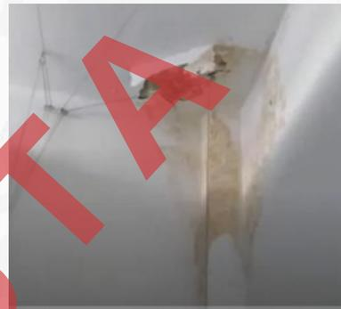
Figura 5: Vazamento em tubulação embutida
